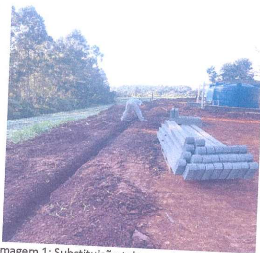
Imagem 1: Substituição tela e postes Alambrado
