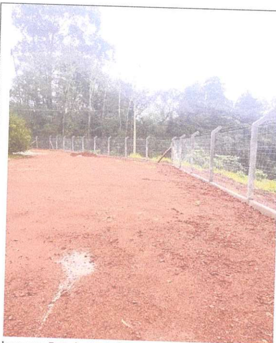
Imagem 5: Substituição tela e postes Alamedado
