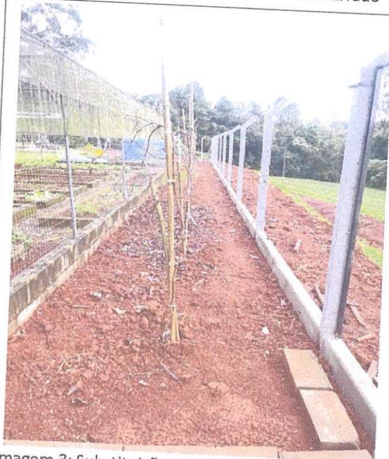
Imagem 3: Substituição tela e postes Alambrado
