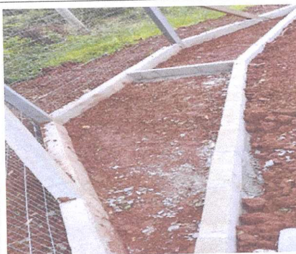
Imagem 2: Instalação da estrutura para a composteira doméstica. (19/09/2024)
