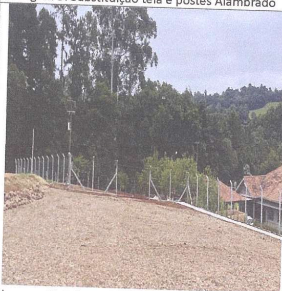
Imagem 7: Substituição tela e postes Alamedado
