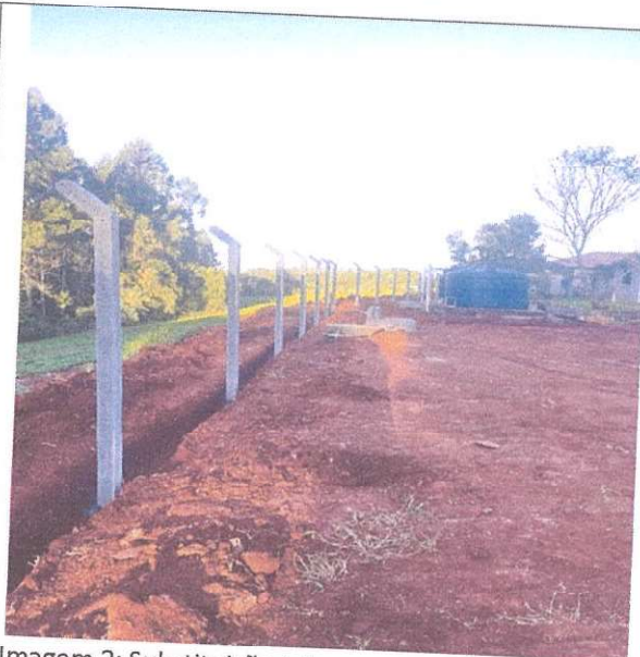
Imagem 2: Substituição tela e postes Alambrado
