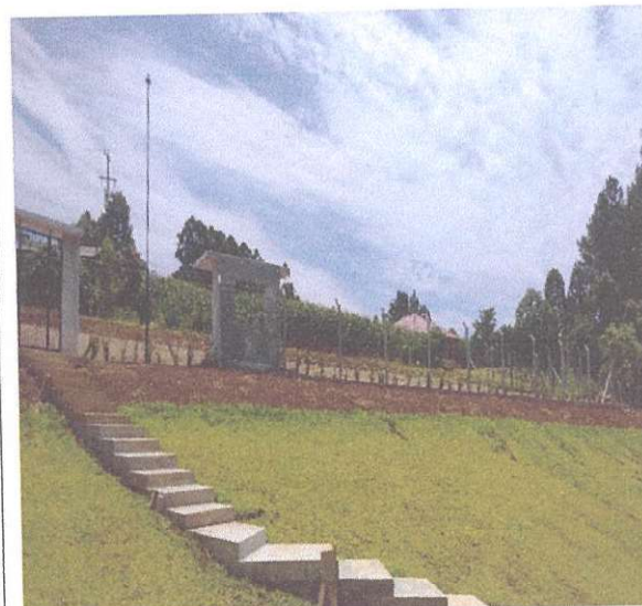
Imagem 20: Embelezamento do alambrado novo instalado, com plantio de moreias e grama (21/11/2024)
