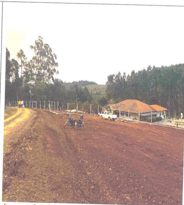
Imagem 6: Substituição tela e postes Alamedado
