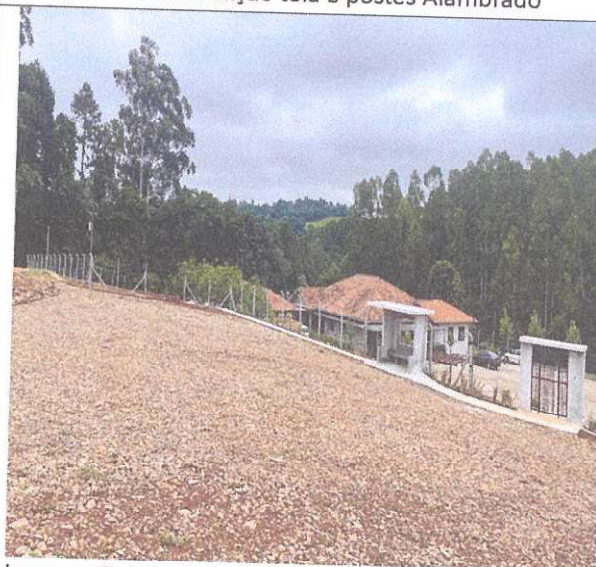
Imagem 8: Substituição tela e postes Alamedado
