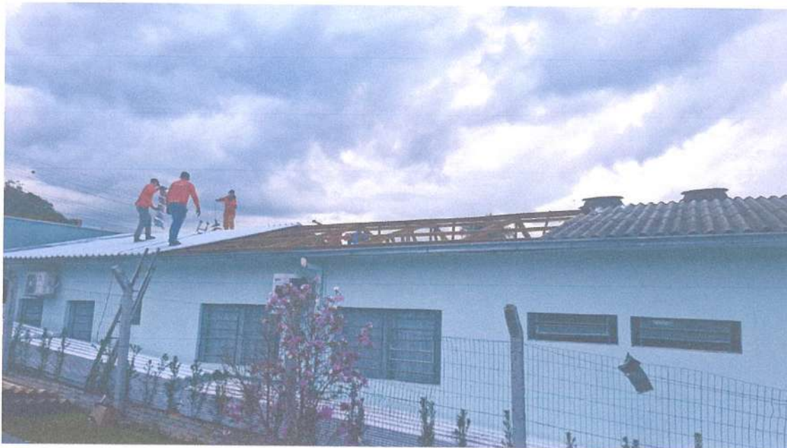
Imagem 03 - Readequação do telhado
