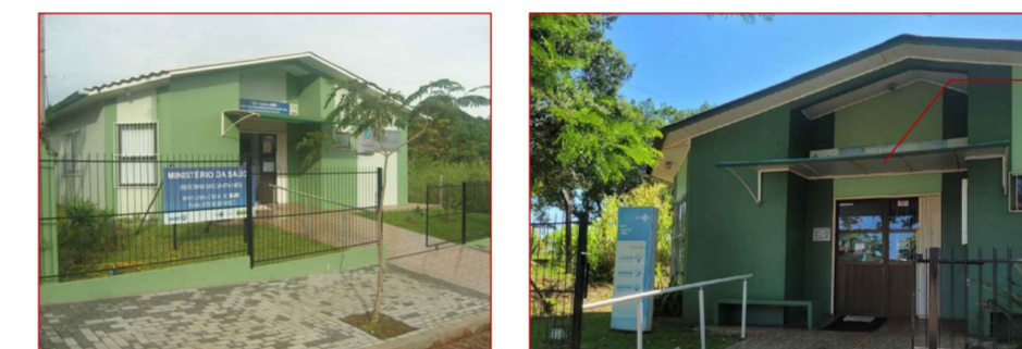
toldo existente a remover
